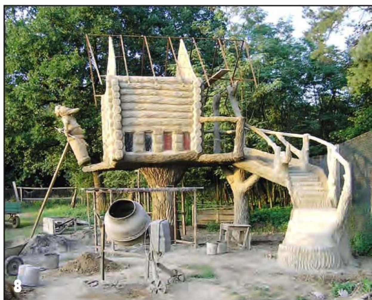
Все несущие конструкции подготовлены под покраску. Осталось смонтировать крышу.
