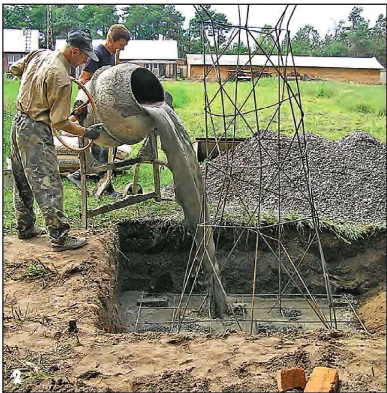
Устройство фундамента. В подготовленный котлован укладываем арматурную сетку, устанавливаем каркас опор и заливаем бетон.
