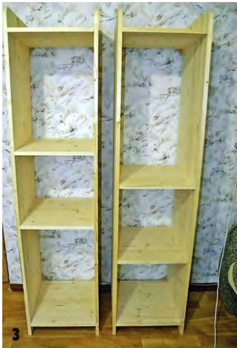
Каркасы пеналов собраны предварительно: саморезы не затянуты.
