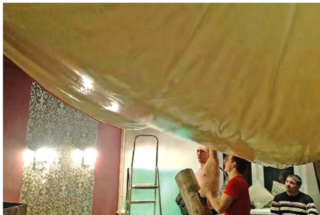
Закреплённое по углам полотно дополнительно прогревают.
