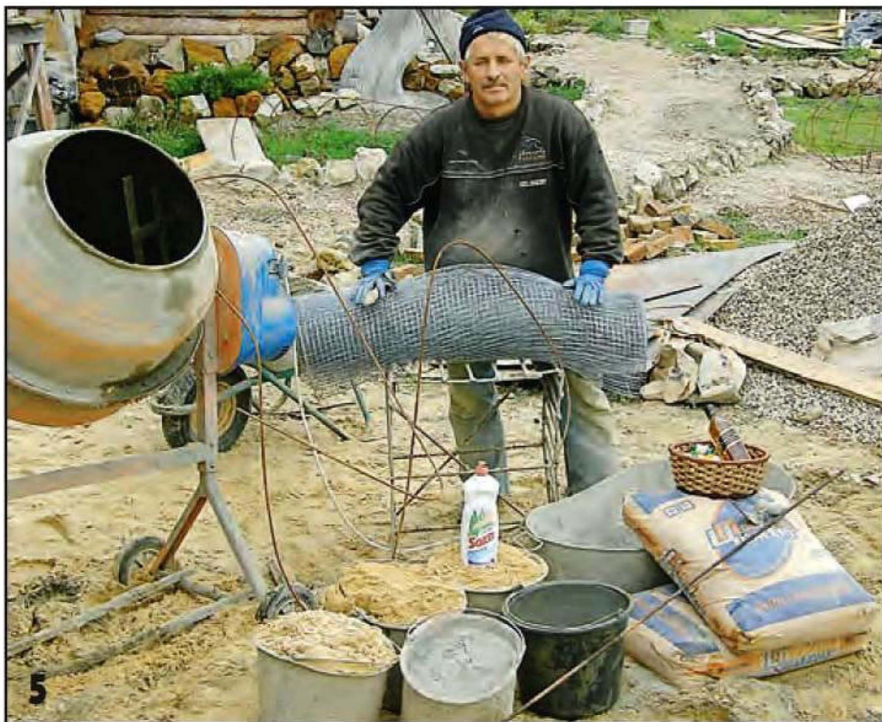
Раствор для отделки сказочных домиков и скульптур готовим из песка и цемента в соотношении 3:1. В раствор добавляем небольшое количество средства, предназначенного для мытья посуды.
