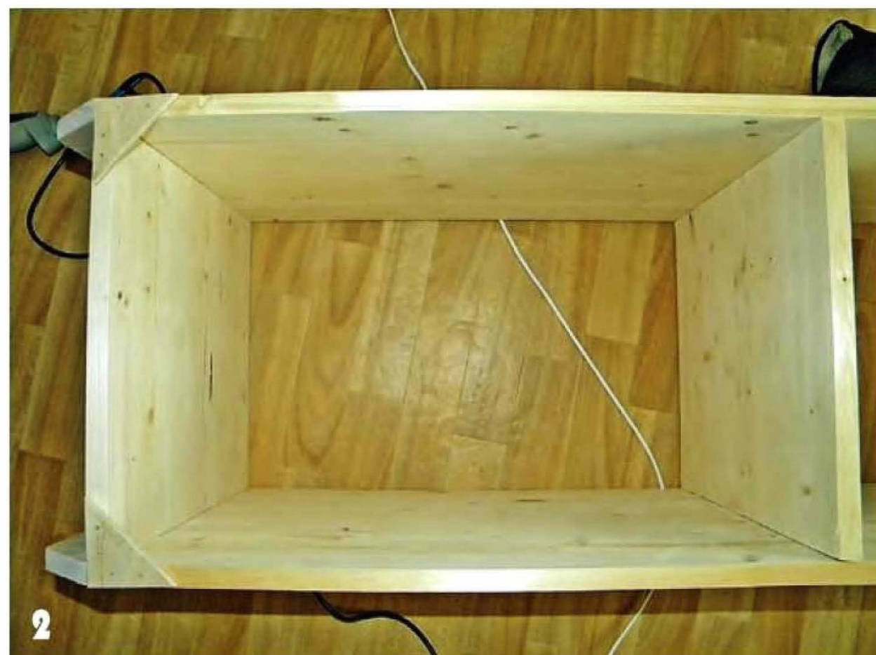
2 Для большей жёсткости каркаса пеналов с тыльной стороны прибиты фанерные косынки.
