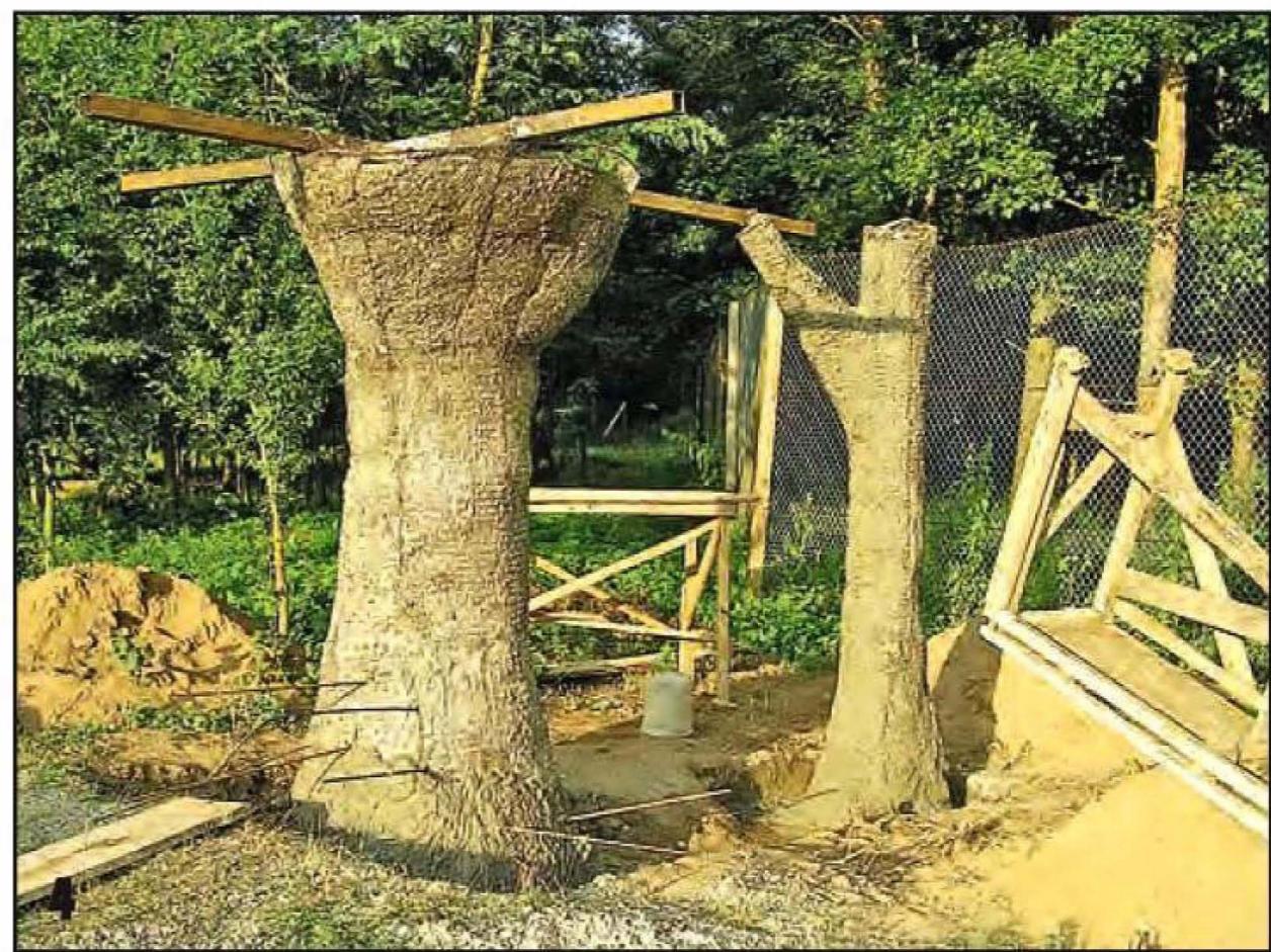
Две опоры для избушки отлиты. При последующей отделке главная опора станет куриной лапой, а вторая — стволом дерева.
