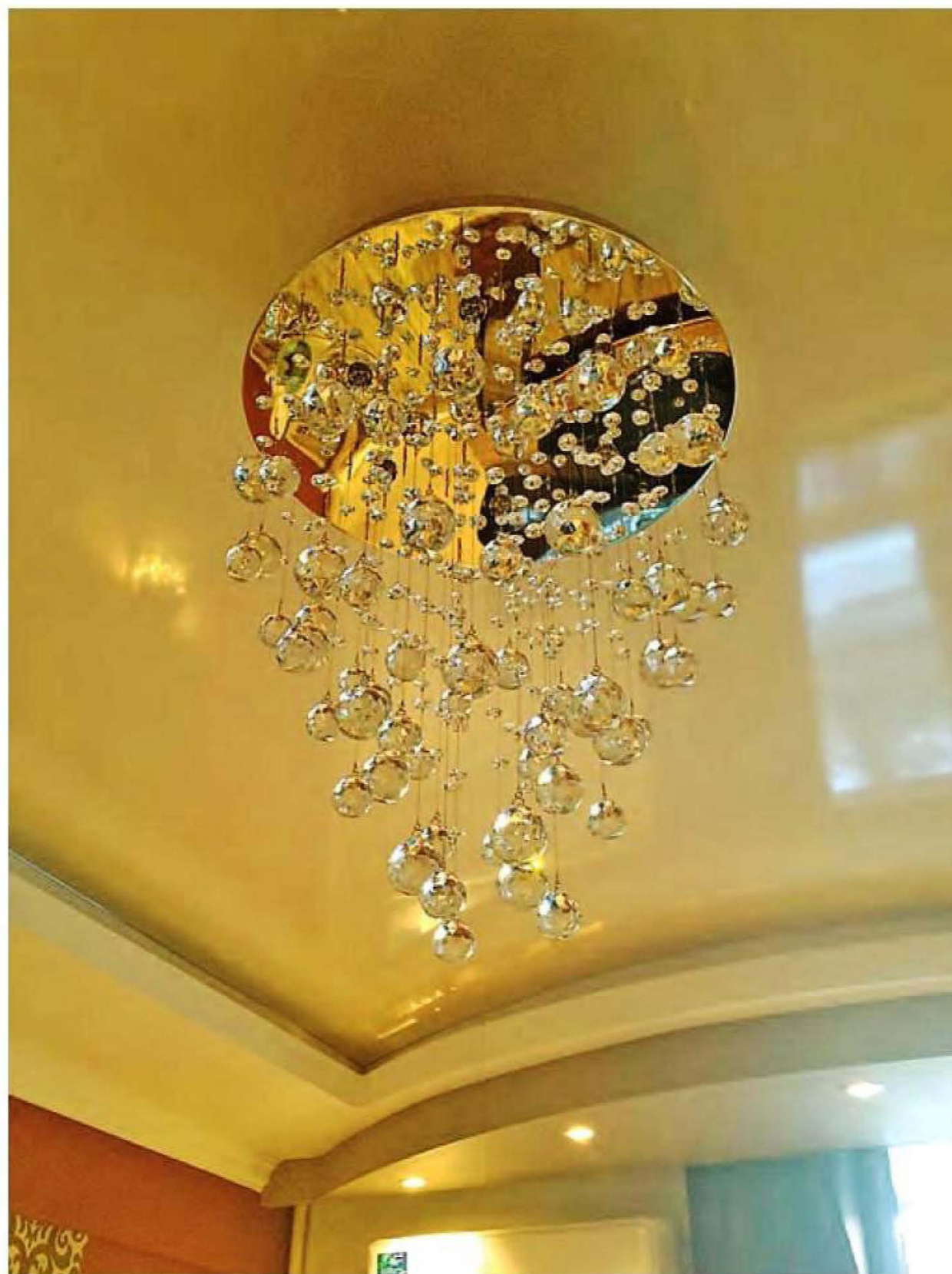
По мере остывания полотно даёт усадку, приобретая нужную форму. На заключительном этапе вешают светильники.
