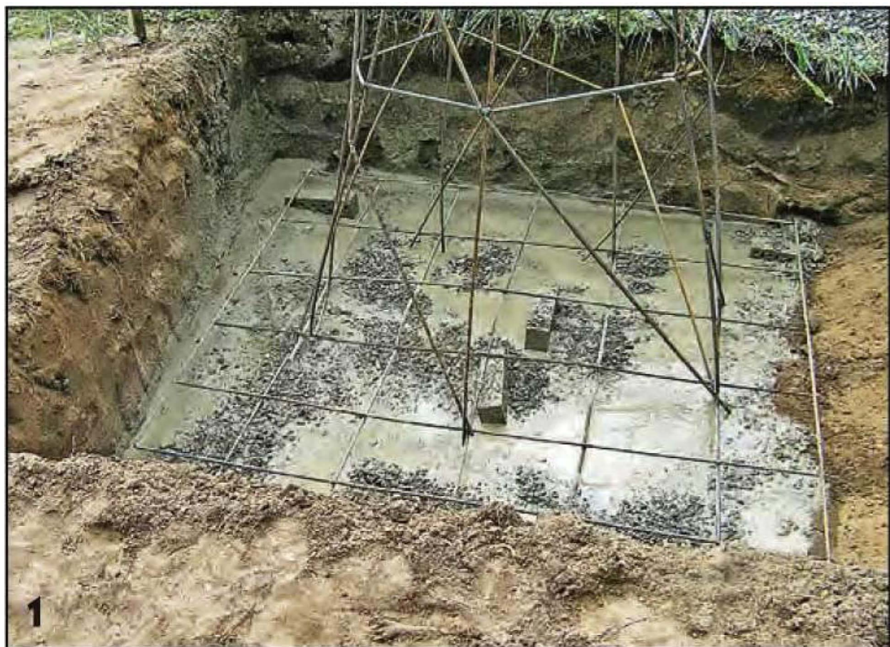
Устройство фундамента. В подготовленный котлован укладываем арматурную сетку, устанавливаем каркас опор и заливаем бетон.
